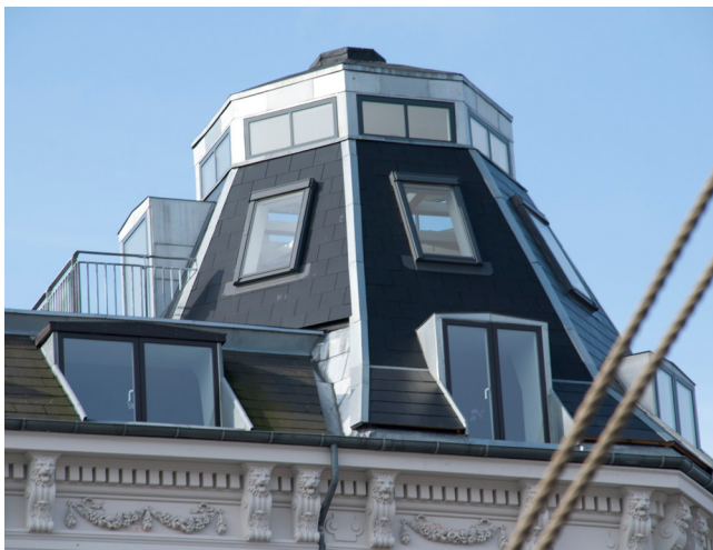
Foto 1. Ombygget tårn, hvor man primært har tilgodeset de indvendige behov.
