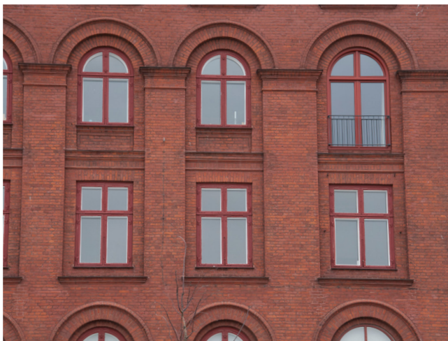
Foto 20. En fransk altan kan i nogle tilfælde være en løsning i stedet for en rigtig altan. I dette tilfælde er den franske altan placeret alene, og facaden vil få et mere homogent udtryk, når de øvrige felter også får etableret franske altaner.
