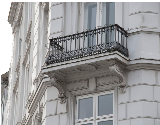
Foto 21. Altanbunden er dekoreret, forkannten er profileret og bunden indgår naturligt med gesimsen.
