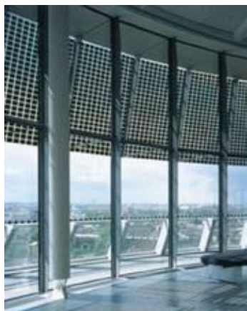
Eksempel på facadeintegrerede solceller.
