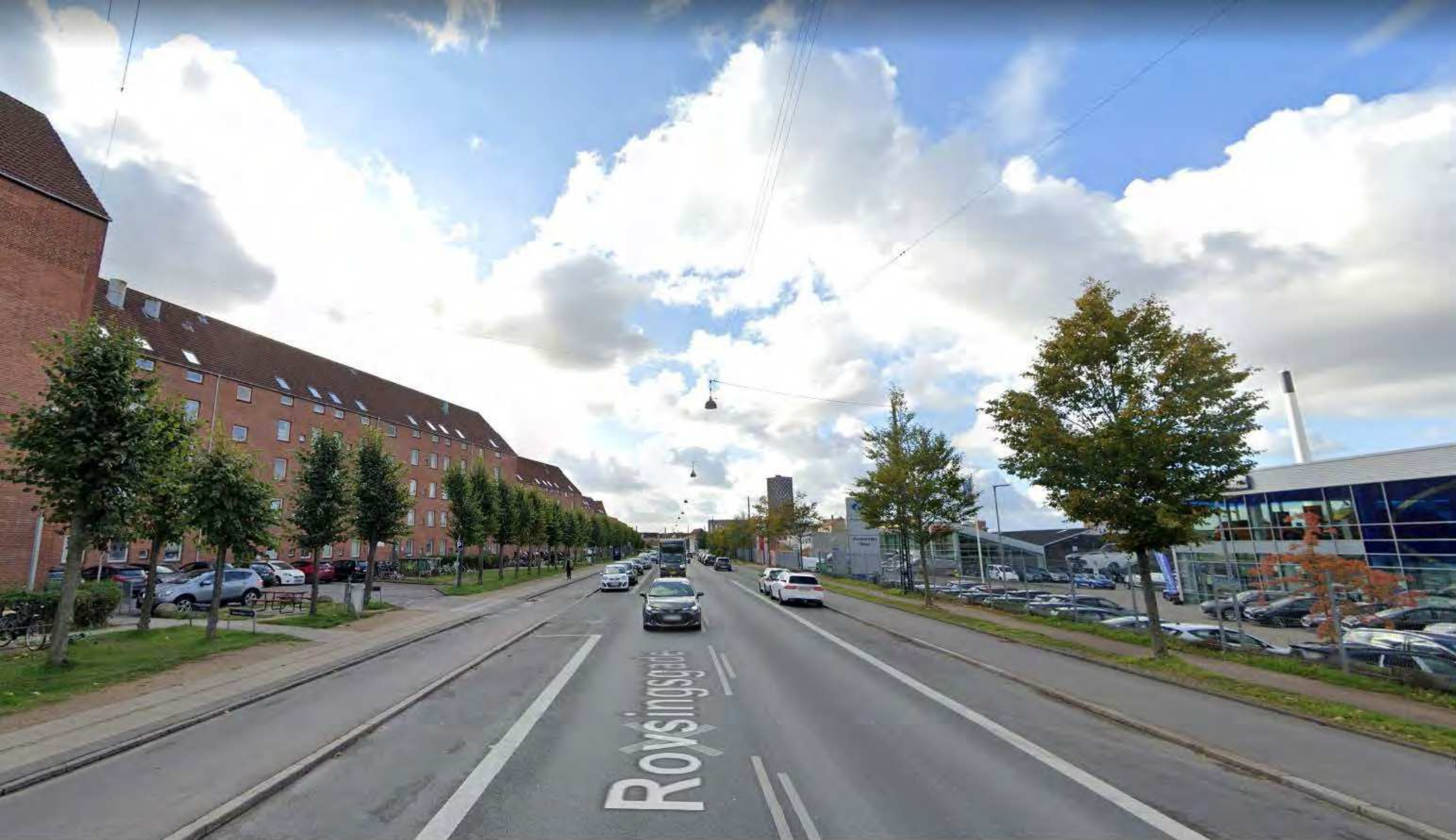
Røvsingsgade i dag
