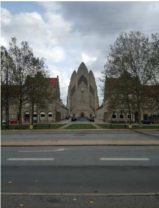
Grundtvigskirken - forrest Bispebjerg Torv og Frederiksborgvej
