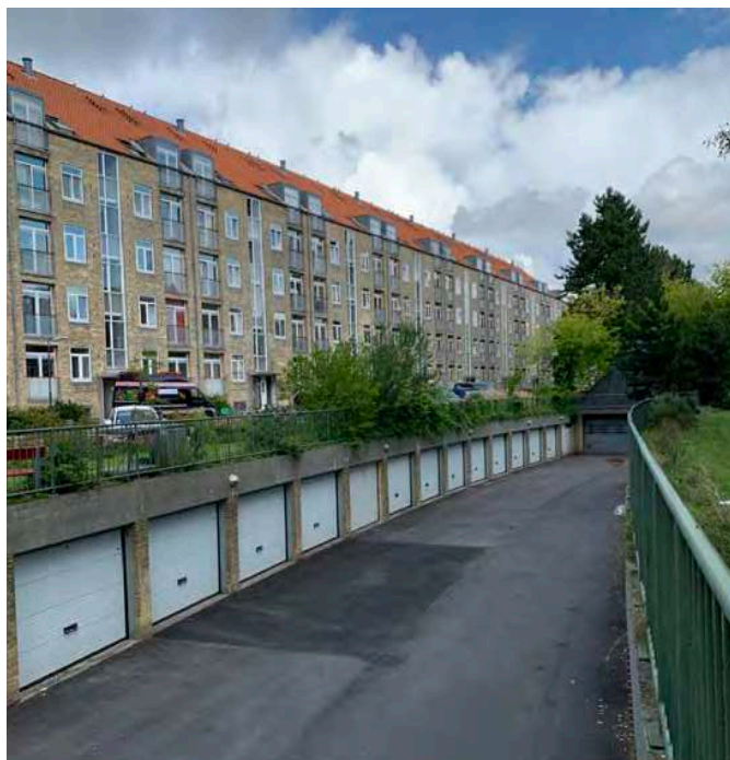
Parkeringsanlæg i Bispeparken
