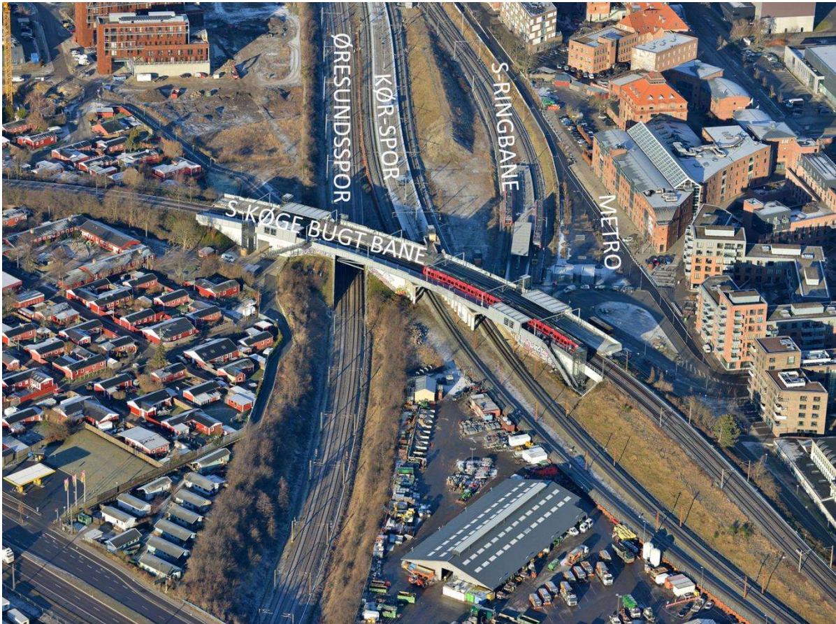
Figur 4.1: Ny Ellebjerg Station bliver fra 2024 omstigningsstation mellem metro, S-tog, regionaltog og fjern tog.
