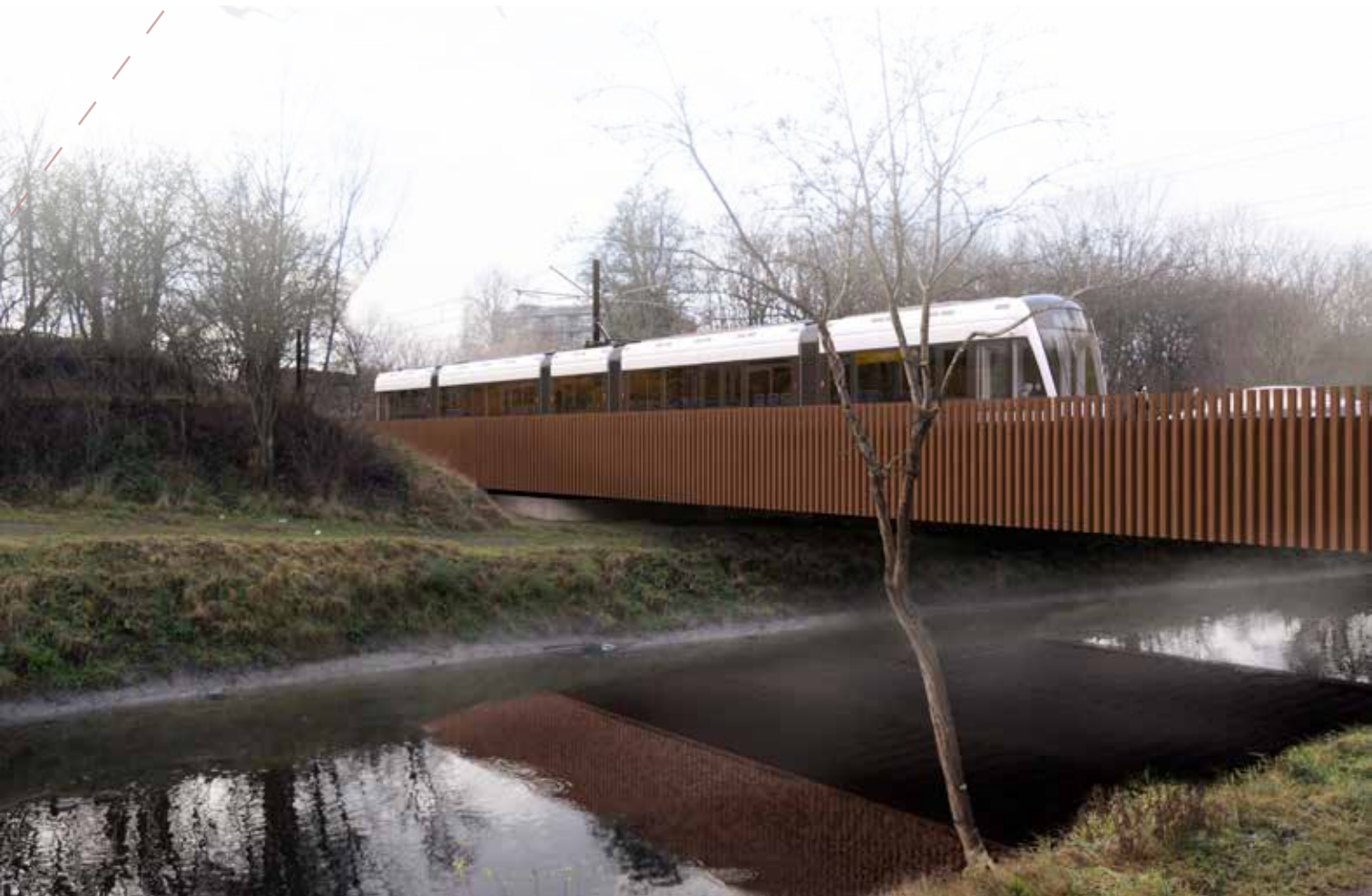
III. 8: Eksempel på broanlæg ved Vestvolden.
