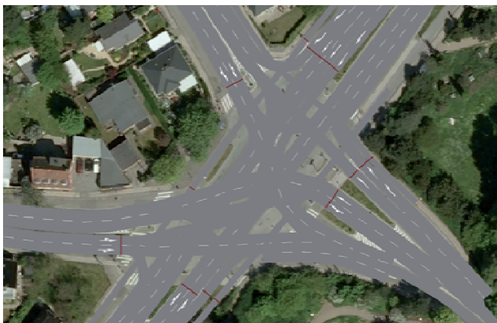
Figur 3.18 Krydset Grøndals Parkvej - Randbølvej - Apollovej.
