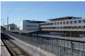
Eksisterende kontorbygning set fra Vanløse Stations S-togsperron.
