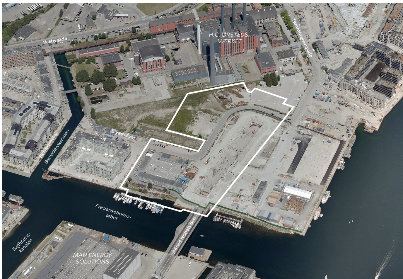
Området set mod nord. Lokalplanområdet er indtegnet med hvid linje, og de vigtigste gader, kanaler og bygninger er navngivet. Luftfoto: Kortforsyningen, 2019.
