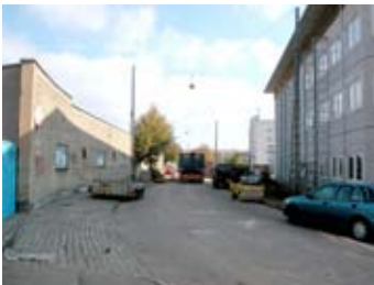
Dortheavej, med det vestlige hjørne af lokalplanområdet i midten af billedet.
