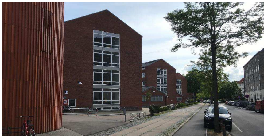
Figur 5: De tre bygninger på Sjællandsgade 38-42 som skal selektivt nedrives.
