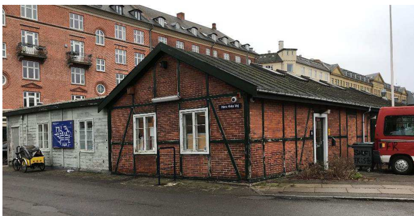
Figur 1: Maskinhuset som skal nedrives selektivt i forbindelse med opførelsen af Center for Diabetes. Set fra Hans Kirks Vej.
