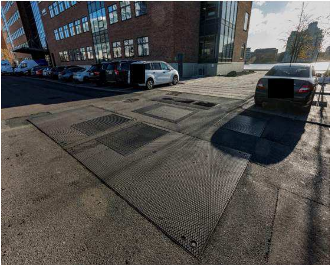
Figur 5.12 Eksempel på parkeringsareal reetableret med dæksler i terræn.
