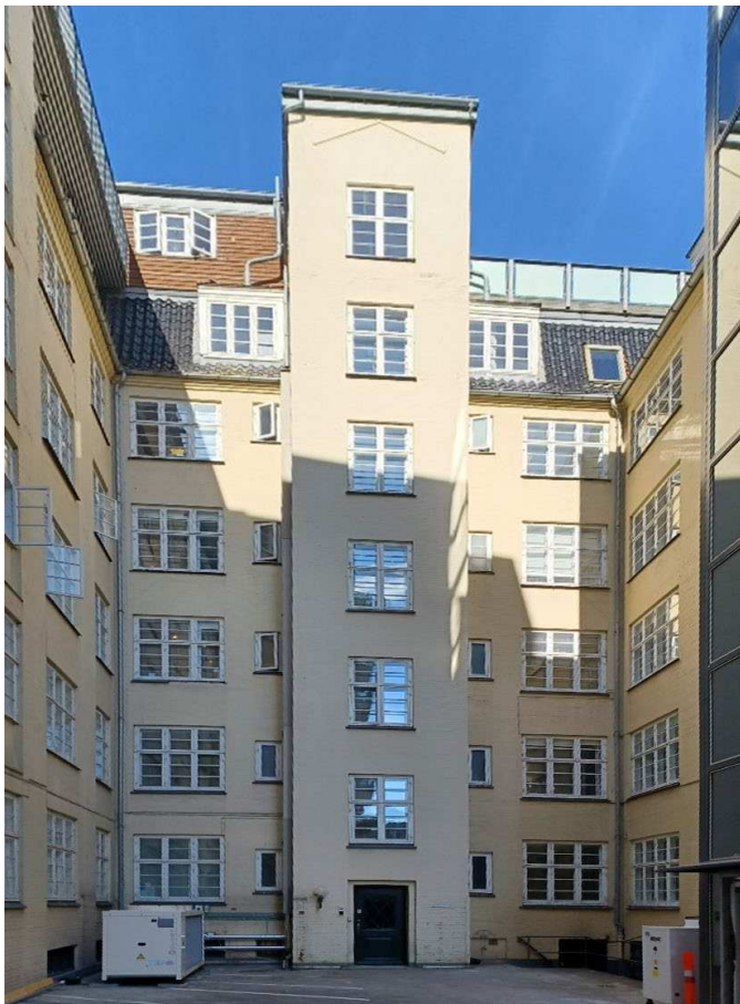
Mellemhusets facade set fra gårdrummet.
