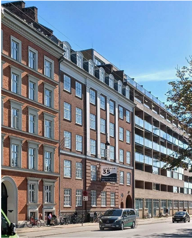
Facade mod Nørre Søgade.
