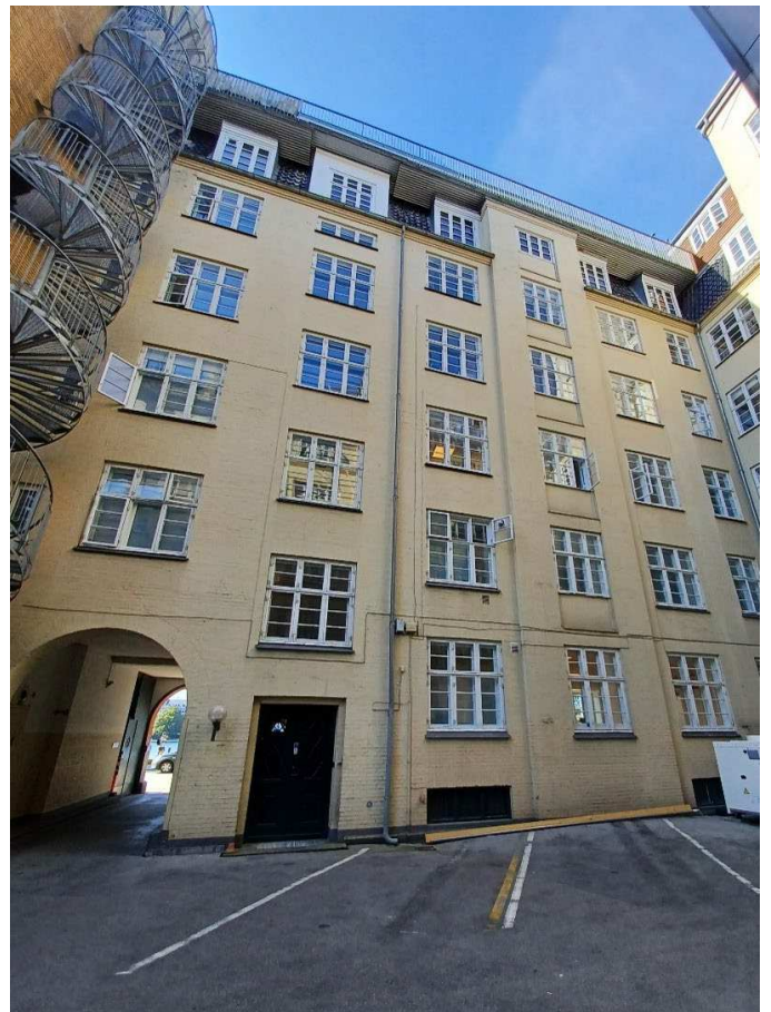
Forhusets facade set fra gårdrummet.
