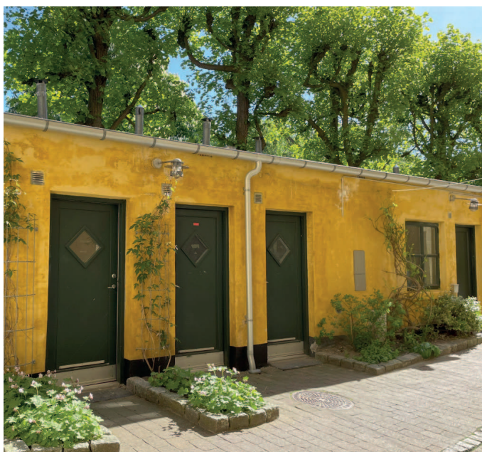
Indeliggende bad i 5 boliger, der mangler
