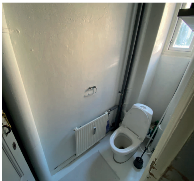
5 boliger har udeliggende wc/bad på bagtrappen
