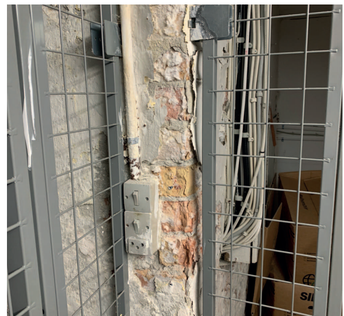
Fugtsikring af kælder
