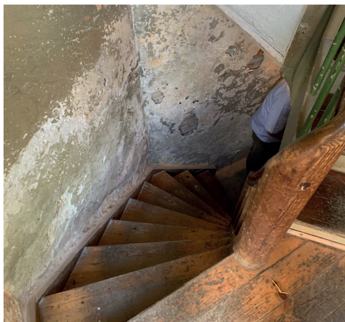
Kælder fugt- og skybrudssikres
