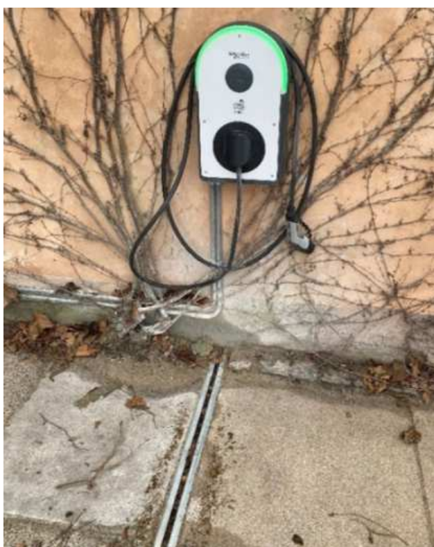
Figur 2 Eksempel på kabelskinne (Gentofte Kommune)
