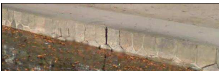
Figur 10. Eksisterende søkant før renovering.
