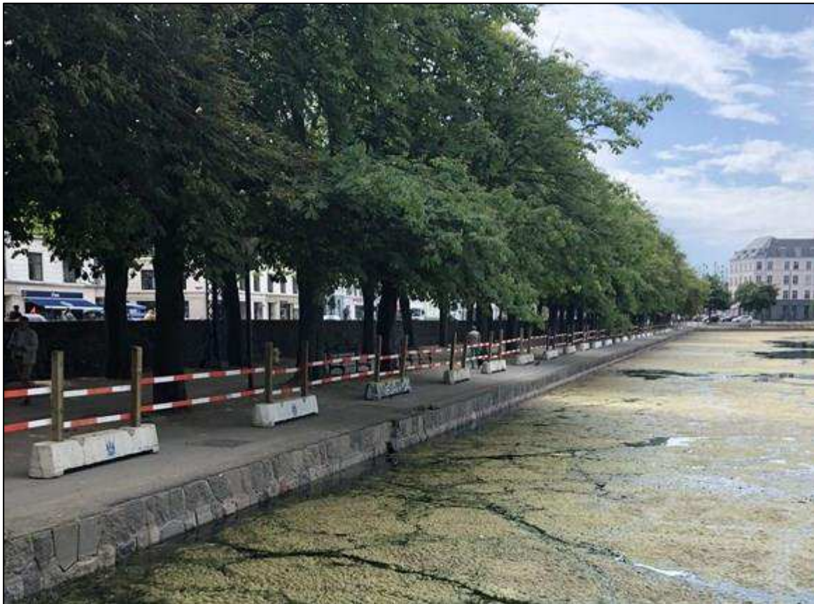
Figur 2. Afspærring ved Sortedams Sø – Østerbrogade.
