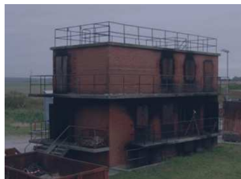
Figur 36: Eksempel eksisterende øvelsesfacilitet
