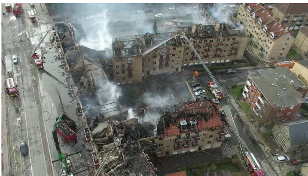
Figur 16: De skadede bygninger på Grøndals Parkvej
