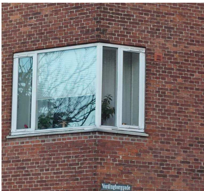
Udskiftning til energivinduer i træ
