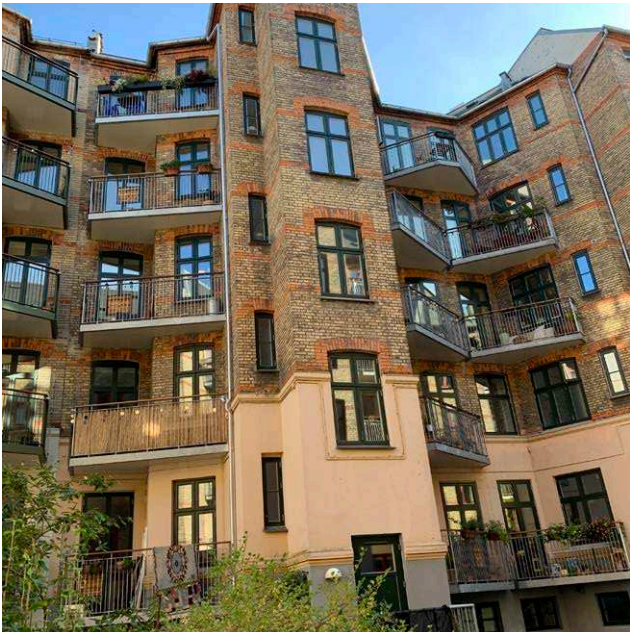
Udbedring af installationsmangler
