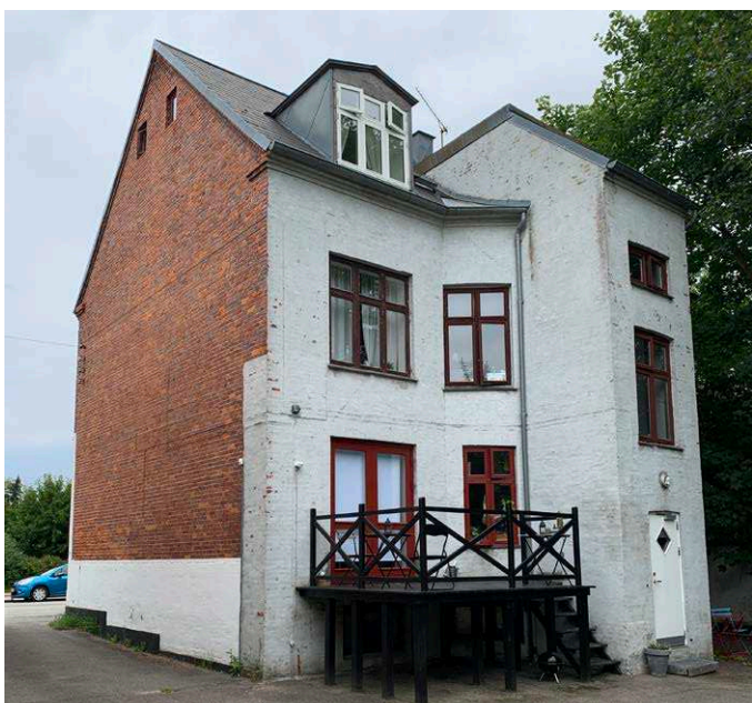
Udskiftning af vinduer og istandsættelse af facade
