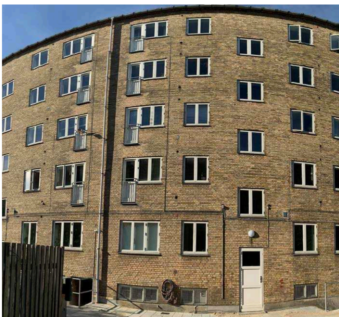
Skybrudssikring af kældernedgange
