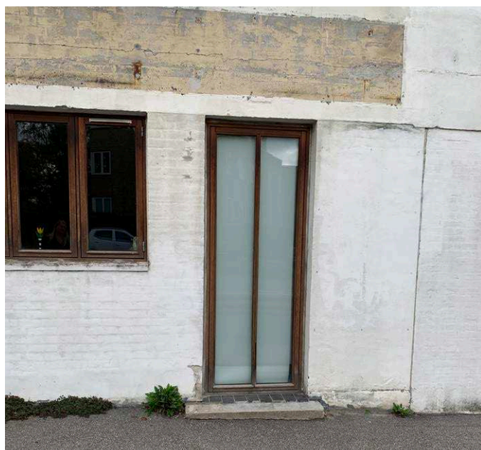
Udskiftning til ventilationsvinduer og efterisolering af facade
