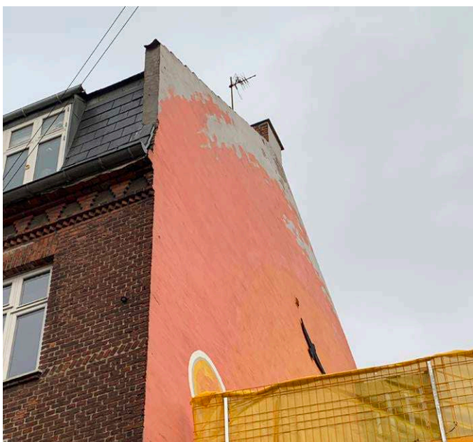
Gavle efterisoleres
