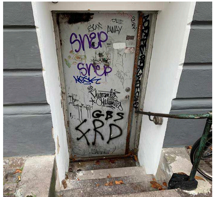
Udvendige døre udskiftes
