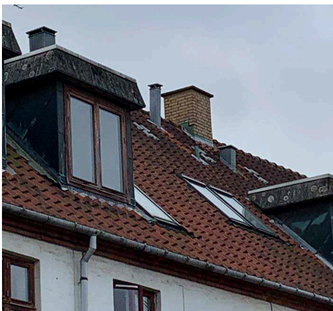
Udskiftning af tag og efterisolering af kviste
