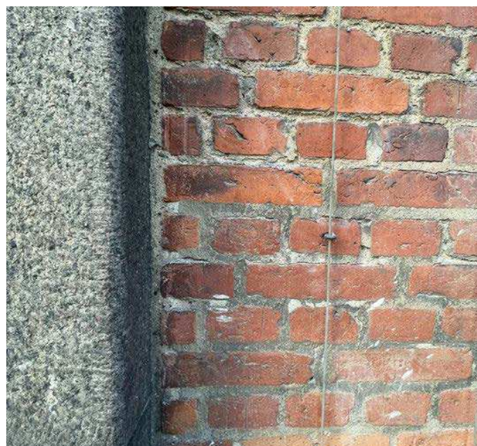
Istandsættelse af gadefacade
