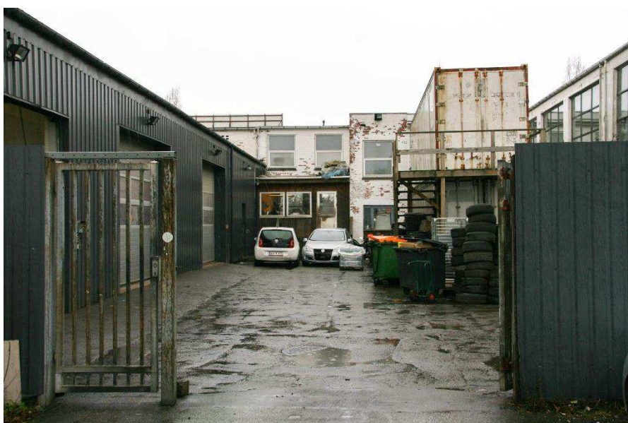
Den SAVE-registrerede bygninger på Yderlandsvej 5 er bevaringsværdig i SAVE klasse 6, hvilket svarer til mellem bevaringsværdi. Opført i 1949.
