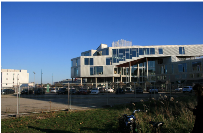
Skolen i Sydhavn umiddelbart over for byggegrunden.
