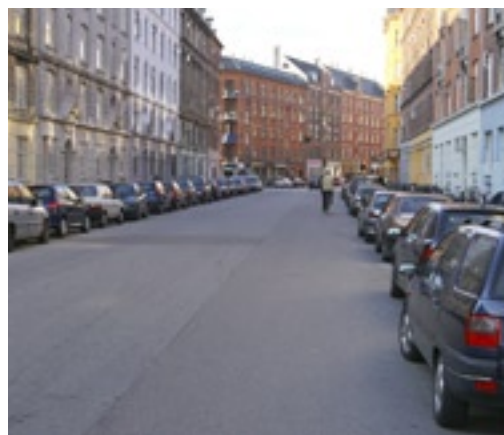
Ægirsgade. Den brede kørebane dominerer gadebilledet.
