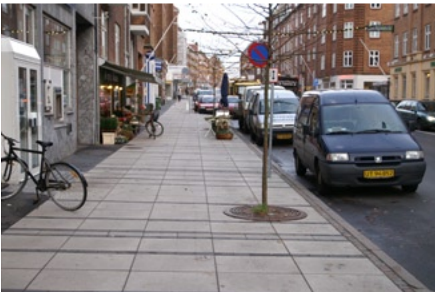
Bredere fortove = smallere kørebaner = større komfort for de lette trafikanter. Foto fra Tordenskjoldsgade i Århus.
