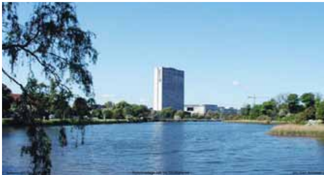
Eksisterende forhold set fra Stadsgraven.
