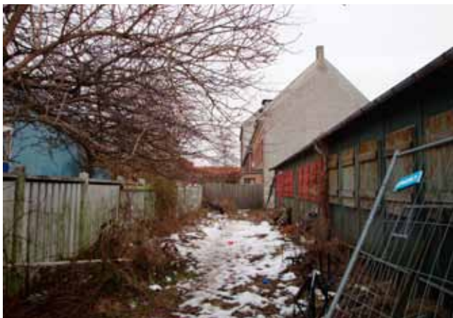
Den forhenværende spejderhytte nedrives for at give plads til børnekulturhuset.
