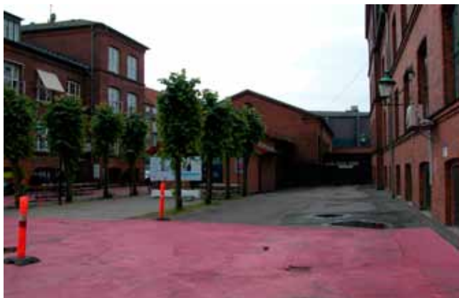
Børneteateret skal indrettes i det tidligere teater "Røde Kro". Der skal derfor laves en tilbygning ml. Amager Bio og "Røde Kro" bygningen.
