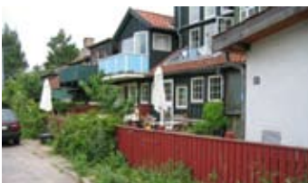
Langs Refshalevej er der opført knopskydninger på de eksisterende bygninger.
