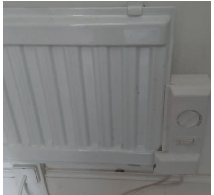
Etablering af nye radiatorer i lejligheder
