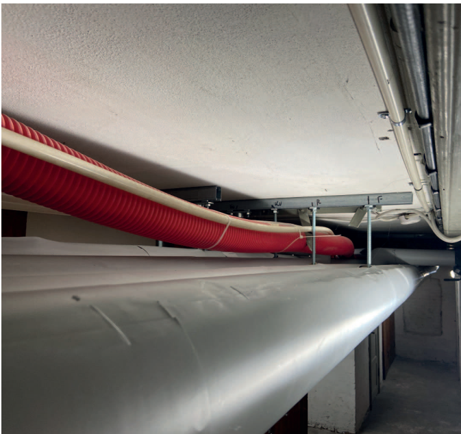
Der efterisoleres mod kælder
