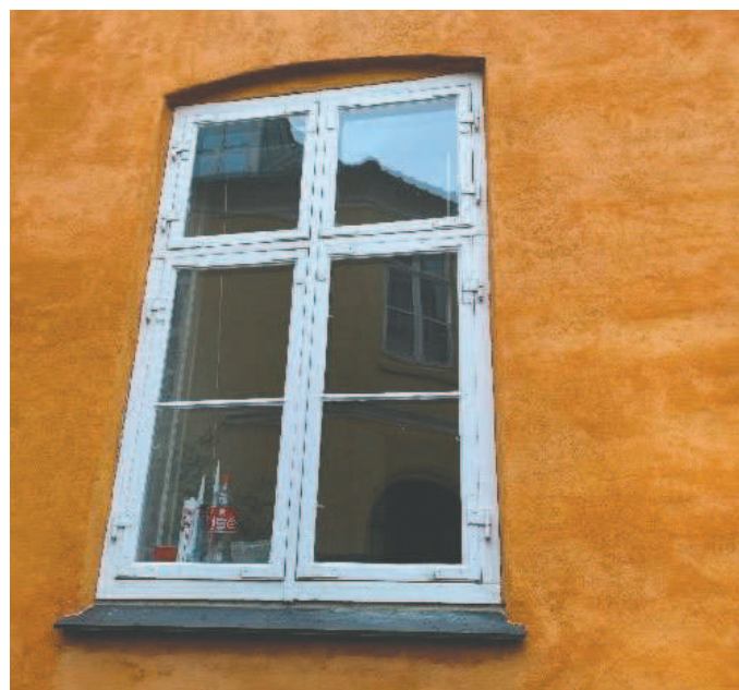
Der etableres forsatsrunder på oprindelige vinduer
