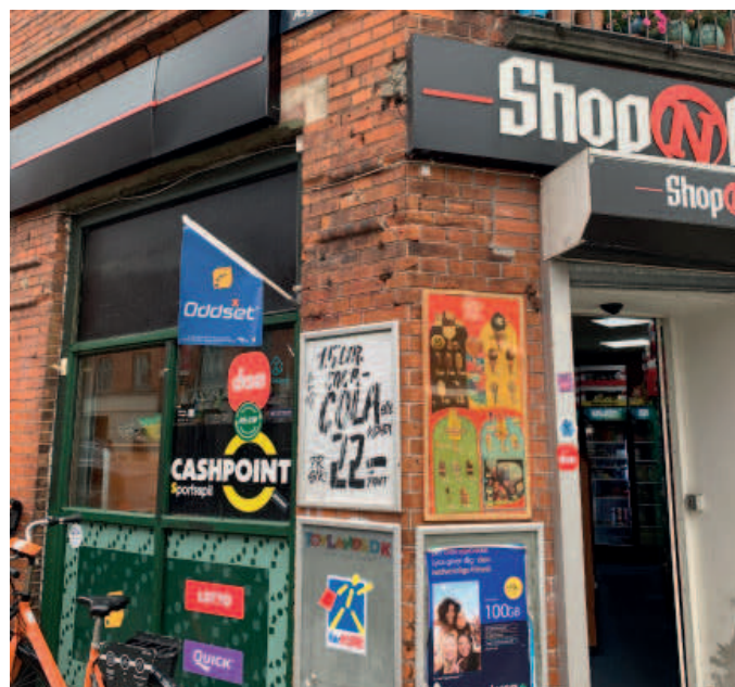
Udbedring af murværk og underfacade
