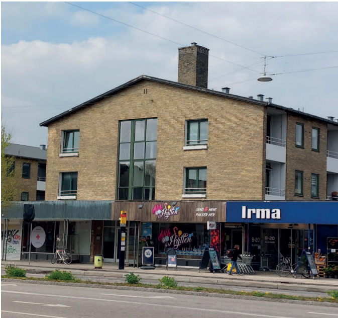
Gadefacade mod Roskildevej
