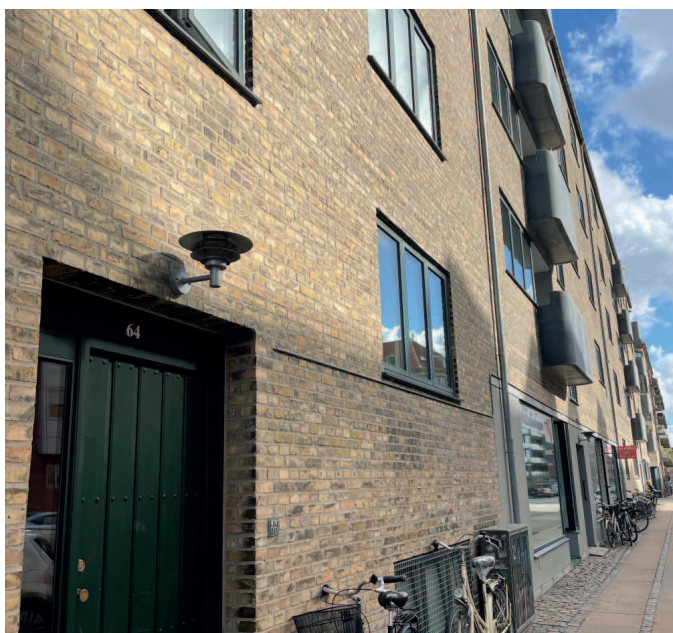
Facaden set fra Tagensvej
