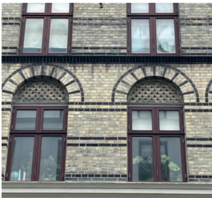
Vinduer udskiftes til koblede trævinduer
