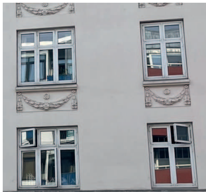
Udskiftning af vinduer til koblede trævinduer
