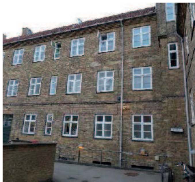
Oprikelige vinduer istandsættes og energiforbedres
