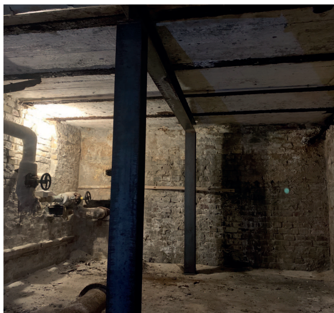
Dæk over portgennemgang sikres ift. korrosion
