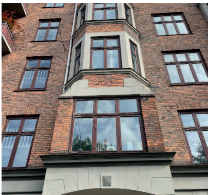
Vinduer udskiftes til koblede- og støjdæmpende trævinduer
