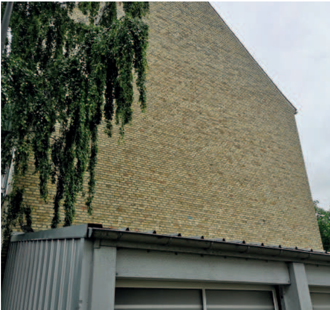
Isolering af gavle
