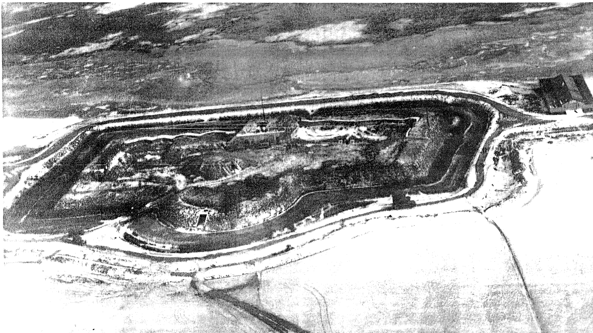
Strickers Batteri set fra vest, til højre ses de to briske, hvor 35½ cm kanonerne stod, 1933. (Flyvevåbnets historiske samling)
