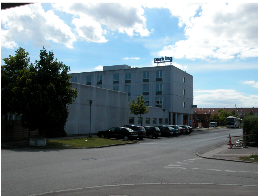
Eksisterende forhold set fra hjørnet ved Jorisvej den 1. juli 2008.
