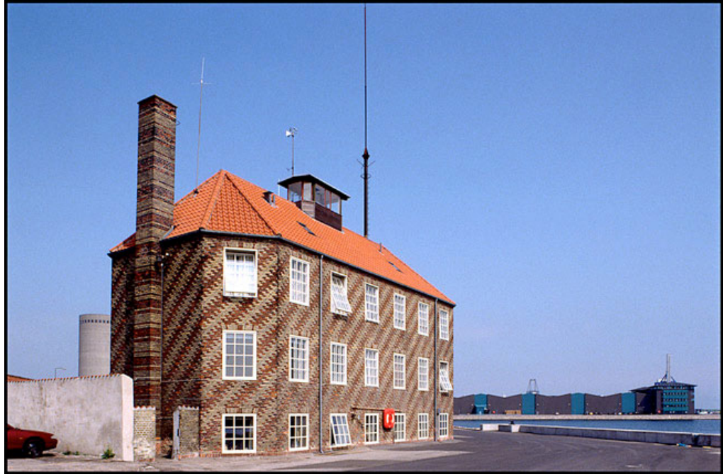
Figur 9-6 Lods- og karantænestationen yderst på Marmormolen. Bemærk udsigtstårn og radiomast. Kilde: www.arkitekturbilleder.dk/billedbasen/popup3.php?id=267
