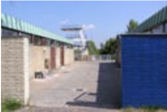
Kig fra Bellahøjvej ind imellem bygningerne og mod udspringstårnet.
