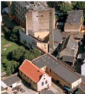
Gavlen på baghuset Vesterbrogade 107E, hvor der kan ske påbygning i 10 etager. Baghuset med det røde tag forudsættes også bevaret.
