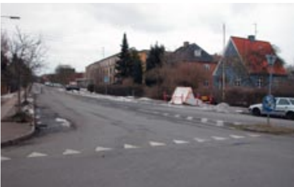
Fuglsang Allé set mod øst med villaer i forgrunden, det eksisterende plejehjem og transformerstationen i baggrunden.
