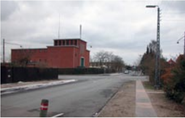
Fuglsang Allé set mod vest med transformerstation i forgrunden, børneinstitution og det eksisterende plejehjem i baggrunden.
