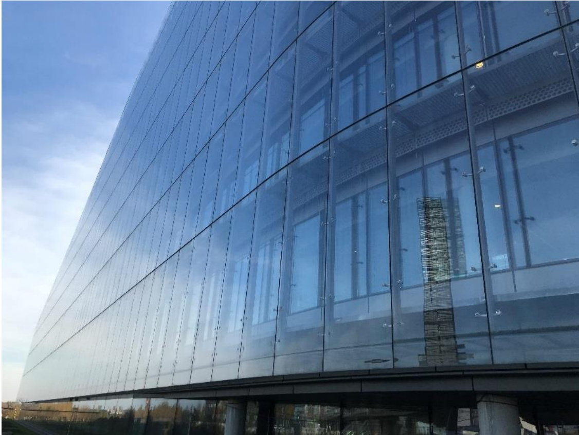
Figur B4 Billedet viser Rambølls kontor i Ørestad, Hannemanns Allé 53, 2300 København S som et eksempel på en erhvervsjendom med dobbeltfacade som støjbeskyttelse mod vej og jernbane. Foto: Rambøll.
