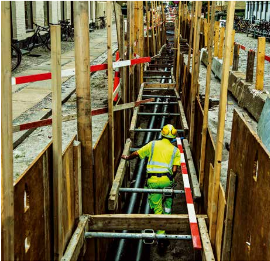
HOFOR har fokus på at koordinere gravearbejde med andre aktører for at sikre fremkommeligheden i byer, der er i udvikling og udbygning.
