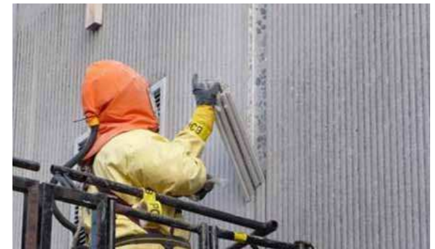
RENSNING AF BYGNING INDEN NEDRIVNING
