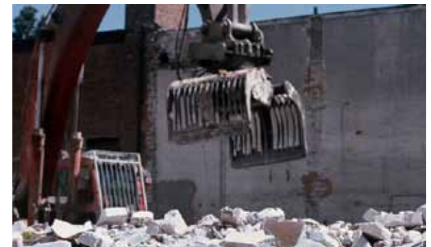
NEDRIVNING AF BYGNING
