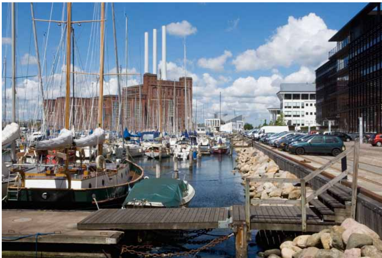
Svanemøllværket set fra Kalkbrænderihavnen. Et eksempel på den store skala i havnerummet.
