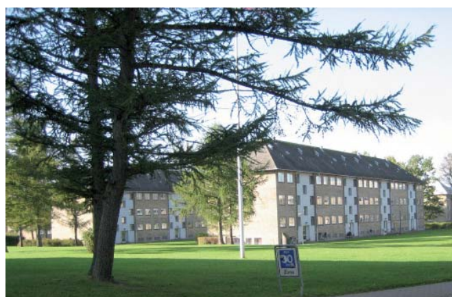
Plejecenteret Bystævneparken (øverst) og det almene boligområde Voldparken, der begge ligger nord for Frederikssundsvej.
