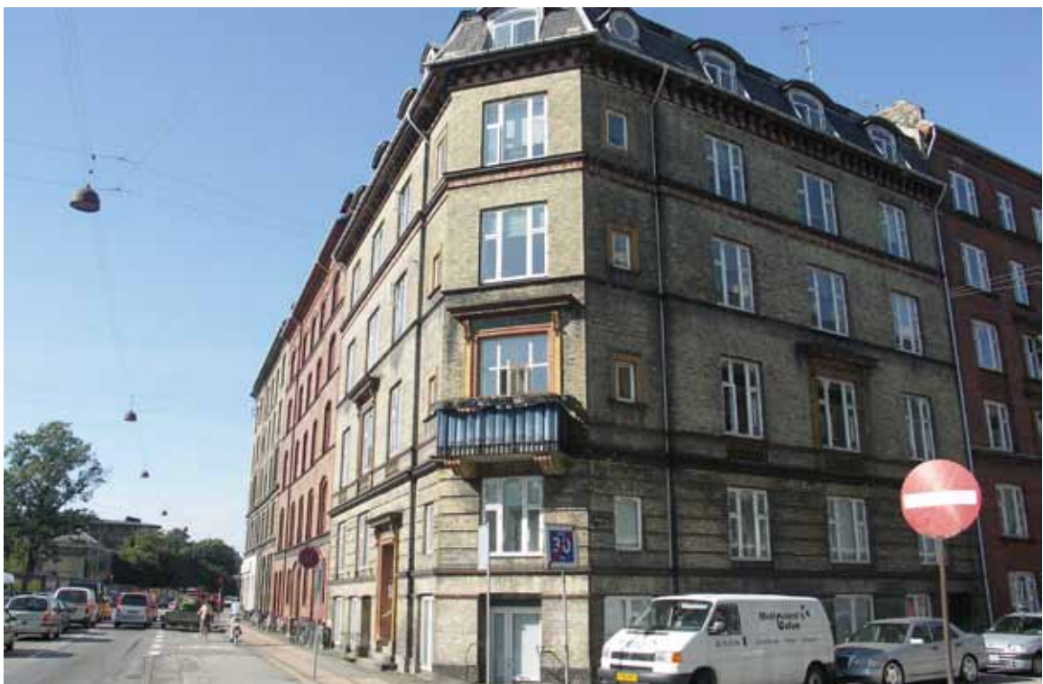
Karré ved Ågade med Krügersgade til højre.
