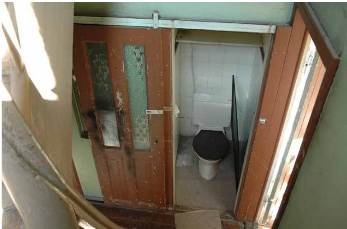
Deletoilet på bagtrappen i Geislersgade-karreen for ombygning.
