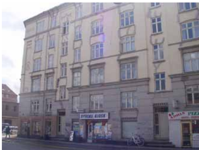
Kastrupvej 4-6 før byfornyelse.
