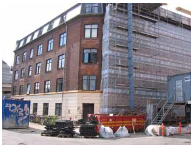
Bregnerødgade 8-18: Bygningsfornyelse i proces.
