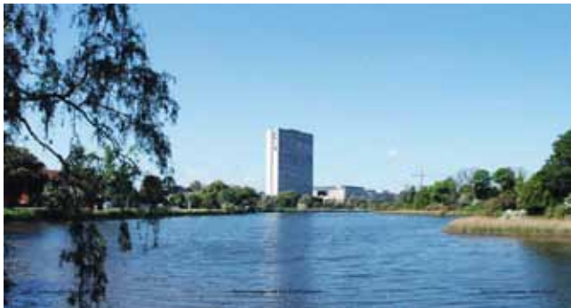
Eksisterende forhold set fra Stadsgraven.
