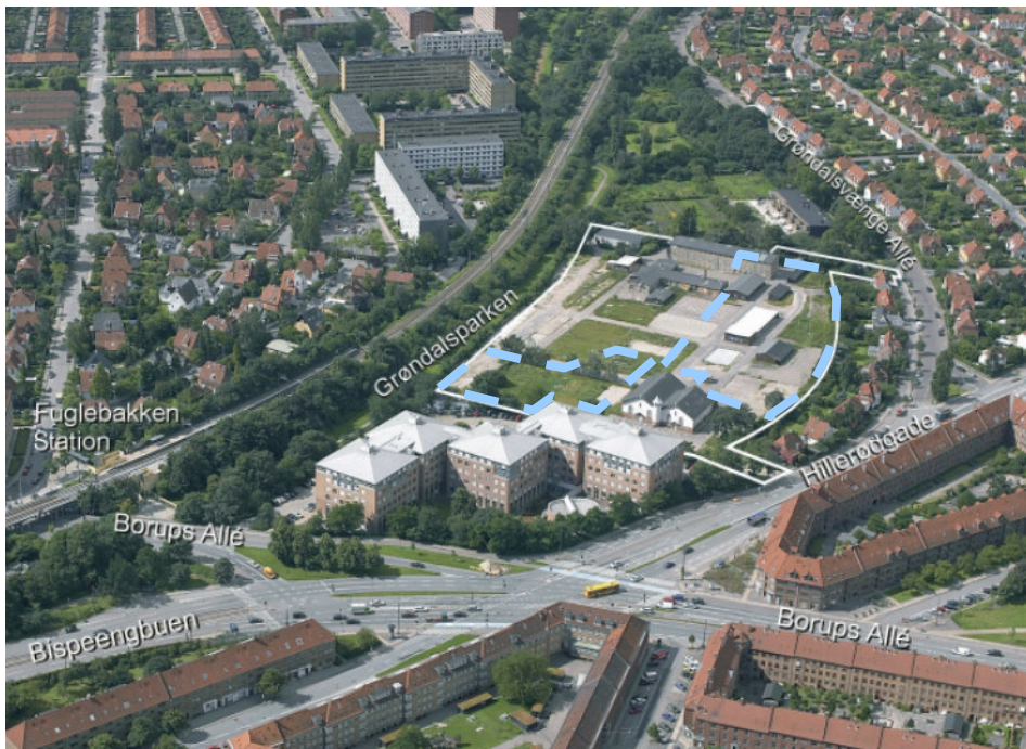
Grunden (matr. nr. 123 og 950 Utterslev) er beliggende ved Hillerødgade, Grøndalsvænge Allé og S-togsbanen (Frederiksberg linien)
