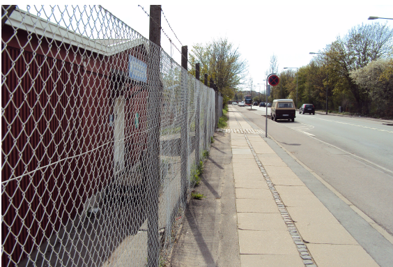
Bygninger langs sydsiden af Kløvermarksvej er placeret lavere end vejareal. Der er støttemur mellem bygning og fortov, hvilket betyder, at dette areal ikke kan inddrages til dobbeltrettet cykelsti.
