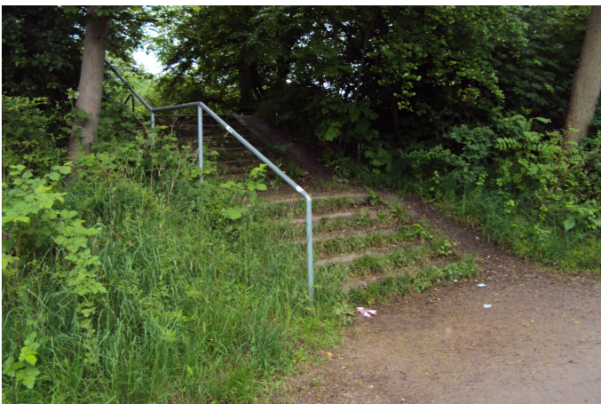
Linjeføring Kommuneplan. Trappe på volden set fra Dyssestien langs nordsiden af volden.
