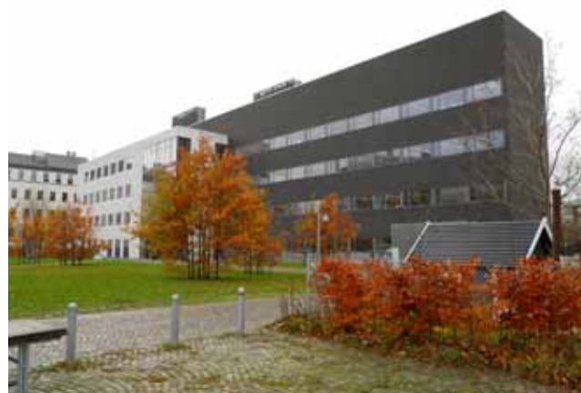
Områdets nyeste byggeri fra 1999 er beliggende mod Jagtvej.
