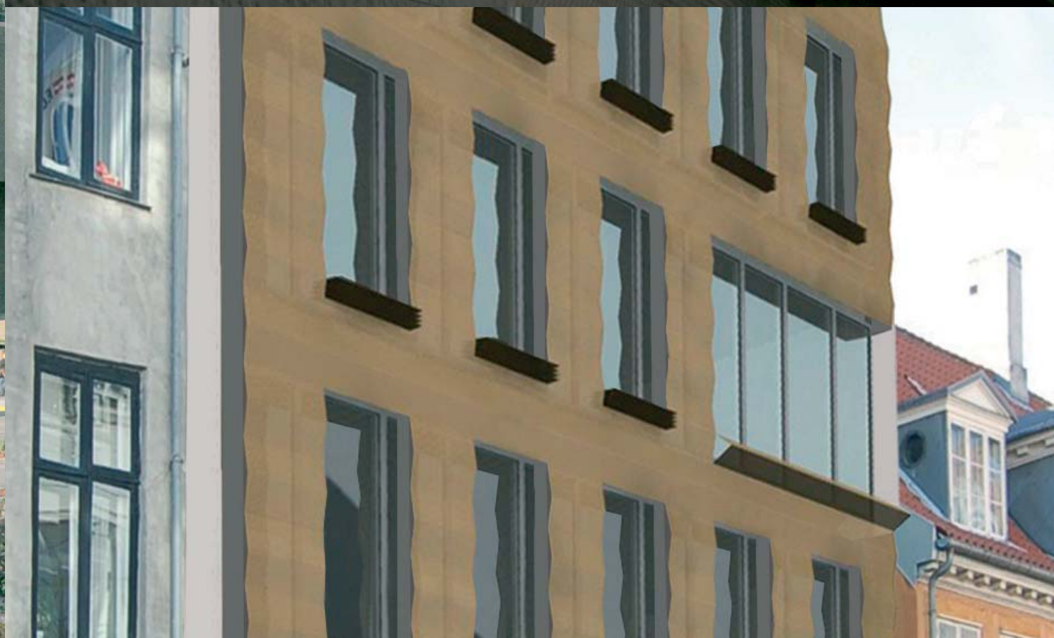
Toldbodgade 13 Hulplade-facade i messing/ tombak, der er mere gullig end kobber.
