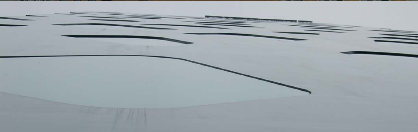
Mikimoto, Tokyo - Toyo Ito Rammeløse vinduers placering i flugt med facadeplan.
