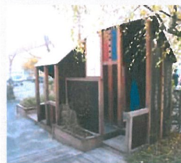
Smørklatten, Christianshavn 2011, efter renovering
