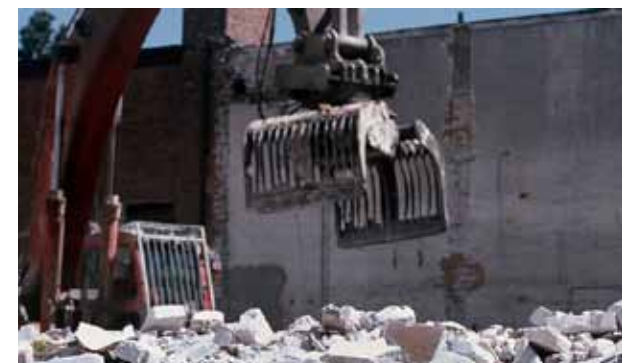
NEDRIVNING AF BYGNING
