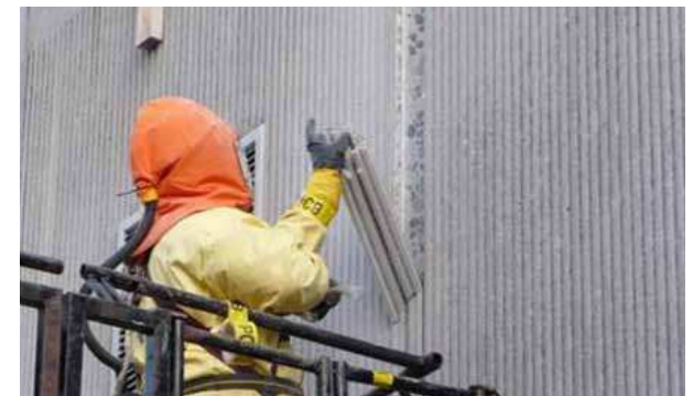
RENSNING AF BYGNING INDEN NEDRIVNING
