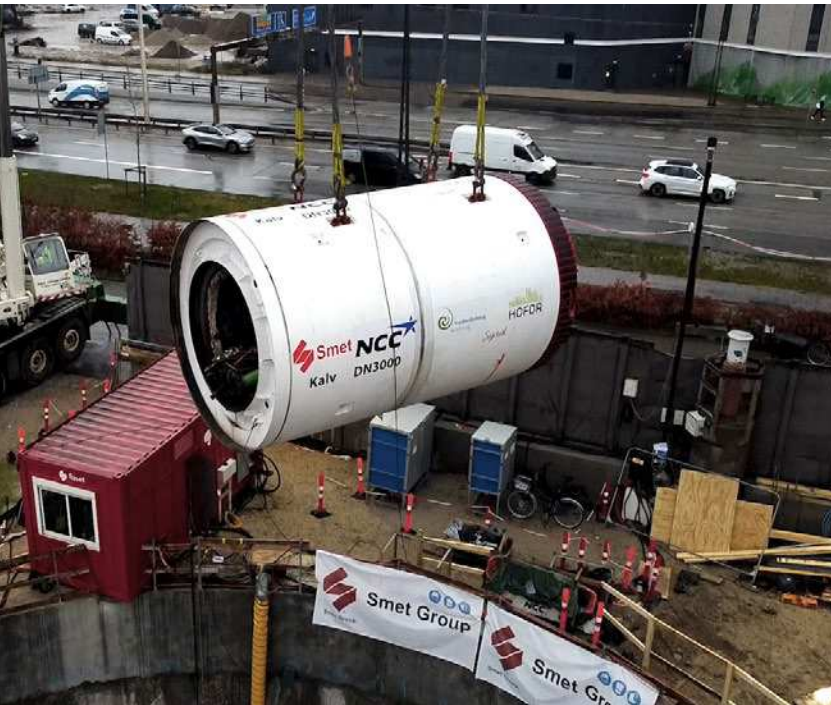
Ankomst af tunnelboremaskinen til Kalvebod Brygge Skybrudstunnel
