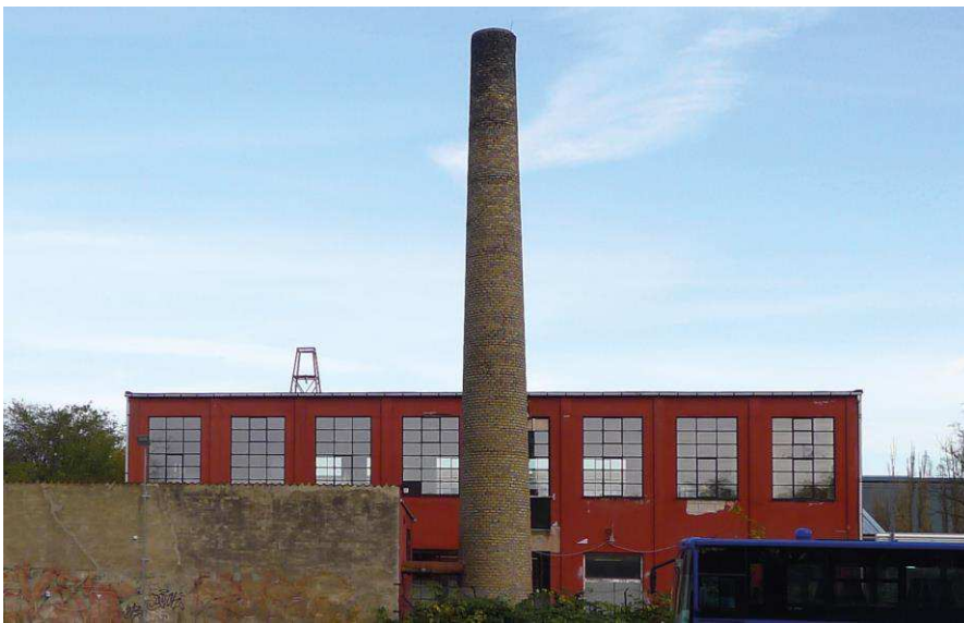
Bygningen på ejendommen Yderlandsvej 1 er ikke registreret i SAVE registreret, men ønskes bevaret i en ny lokalplan med mulighed for ombygning. Opført i 1952.
