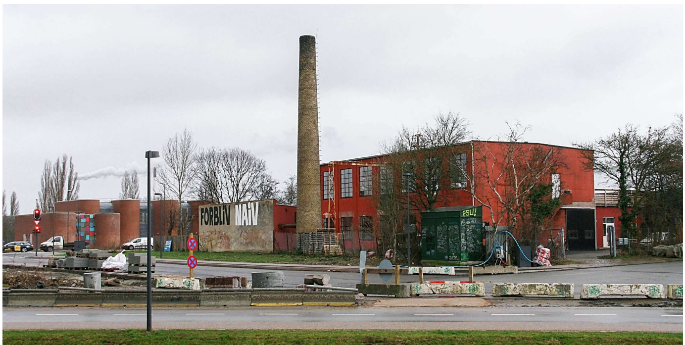
Den markante fabriksbygning og skorsten på hjørnet af Prags Boulevard, Ved Amagerbanen og Yderlandsvej, som gøres bevaringsværdig med lokalplanen. Skybrudsbassin og cykelsti langs Ved Amagerbanen ses i forgrunden.
