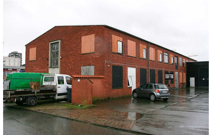
Eksisterende erhvervsbygning i rød mursten, som ligger på det sydlige hjørne af Yderlandsvej. Denne gøres med planen delvist bevaringsværdig.
