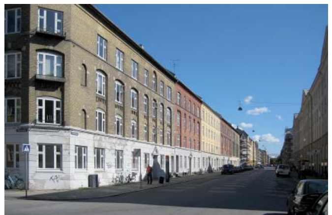
Mange bygninger i Skt. Kjelds Kvarter Nord er fysisk nedslidte.
