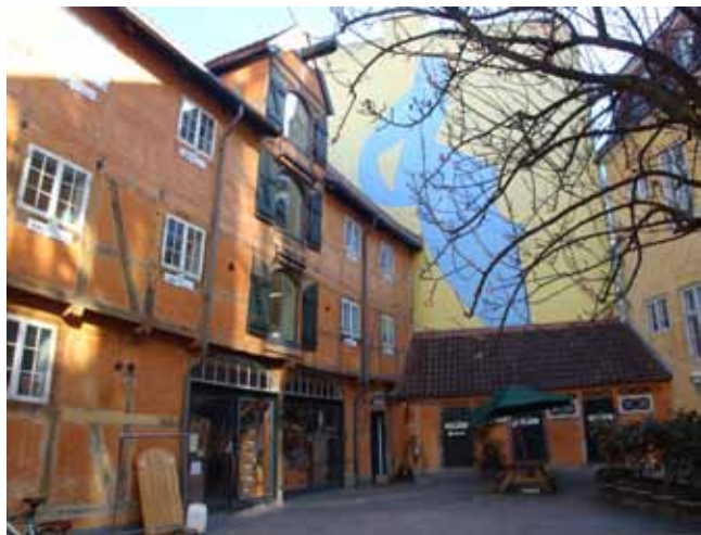
Baron Boltens Gård opført 1755-1771 er et eksempel på Type 1.
