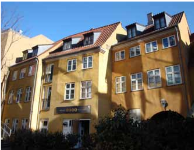
Mindre beboelseshuse med erhverv i stueetagen i Boltens gård
