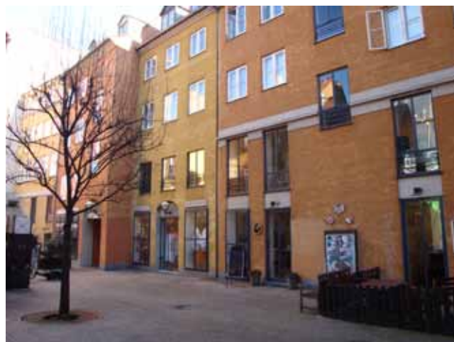
Butiksfacade mod gården Store Kongensgade 5B-19B.
